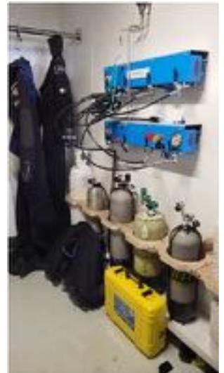
Notre local de plongée avec la rampe Nitrox et Air 200 et 300 bars.
