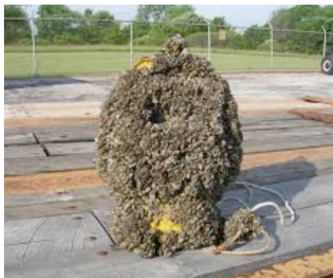
Fig. 5 : Exemple de pompe hydraulique totalement couverte de plusieurs couches de moules zébrées.
